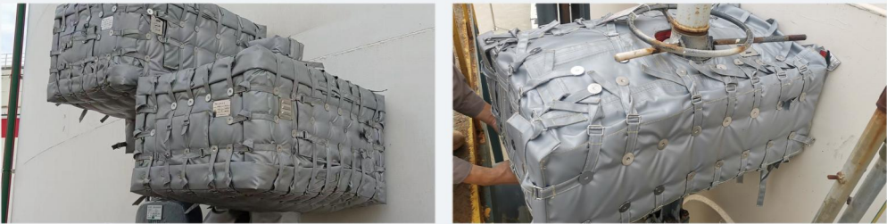
柔性电缆桥架/阀门防火罩现场安装案例
